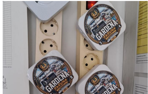
Gambar 3 Pemasangan alat penerima tanda emergency bell di pos komandan
